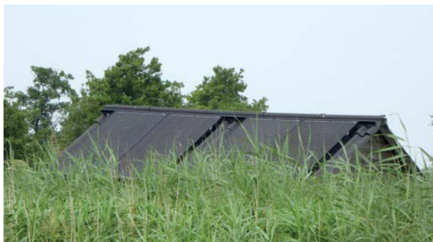
De zonnepanelen van de IBA-installaties
