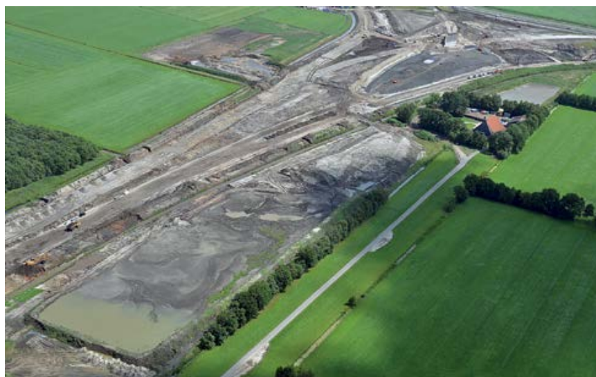
Aanleg van het verkeersplein in Joure, samenwerken met het waterschap ivm lozing vanuit het depot op binnenwater.
