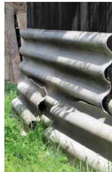
De proeftuin loopt nu en daarin wordt de uitvoering ketenhandhaving asbest getest.
